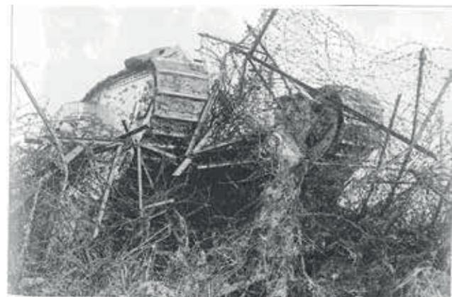
*Bild 03: Britischer Tank bei der Überwindung eines Stacheldrahthindernisses. Ein kleiner Teil der Fahrzeuge war mit speziellen Schneidwerkzeugen (wire-cutter) ausgerüstet. Nach Niederkämpfen der MG-Nester und Niederwalzen der Stacheldrahthindernisse haben die Tanks den Weg für die Begleitinfanterie geebnet.*
