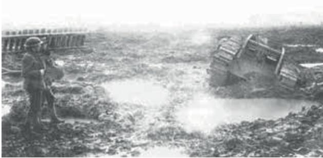
*Bild 04: Neben mechanischen Schäden und Treffern von Artilleriekanonen war das Steckenbleiben in dem vom wochenlangen Artilleriefeuer verwüsteten Gelände an der Westfront eine der häufigsten Ausfallursachen der Tanks.*
